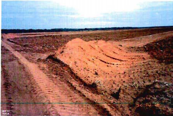
7. Terrasse de base large + cuvette de réception des eaux de ruissellement en bord de piste Terraço de base larga - bacia de recepção das águas de escoamento, na bordadura da pista
